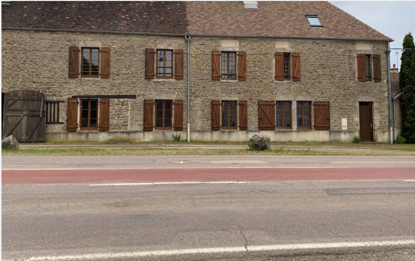
Crédit photo : IMG_0047 (Maison vu côté entrée de l'appartement)
