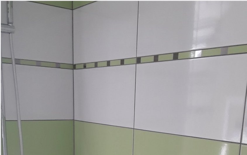
Crédit photo : douche italienne équipée PMR (La Beaun'O)
