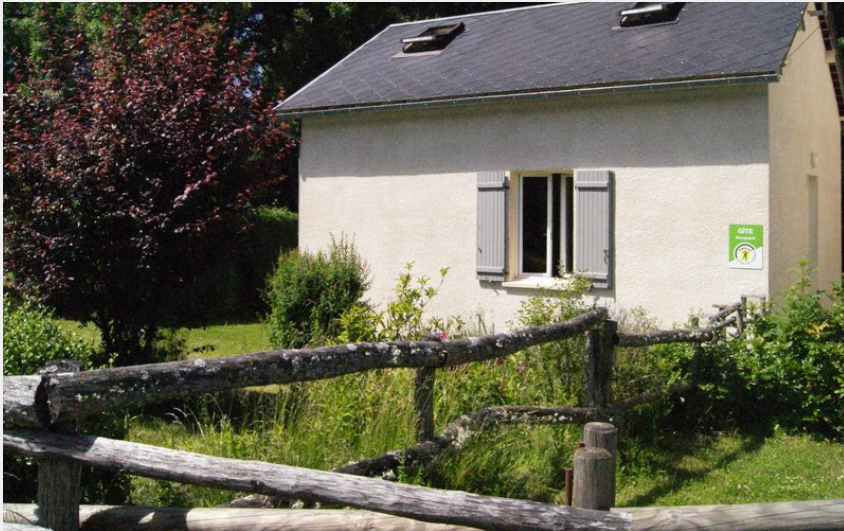
Crédit photo : petit gîte_1 (Gîtes de France)
