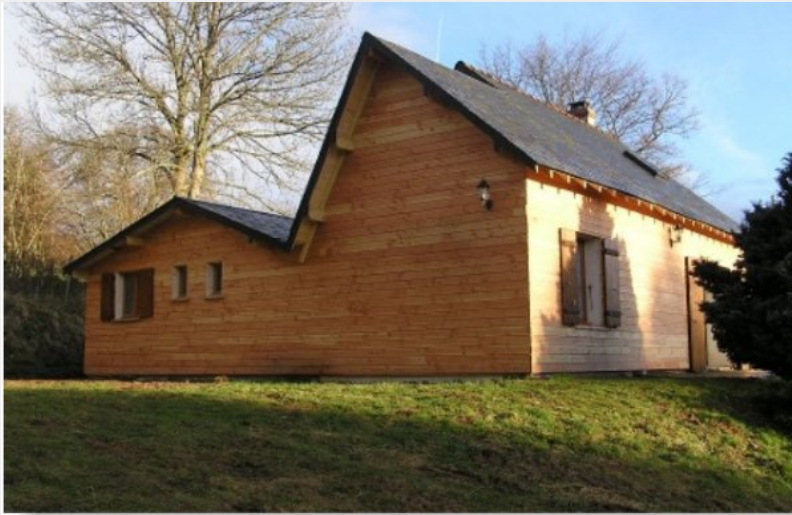
Crédit photo : Maison Bois (ADT 58)
