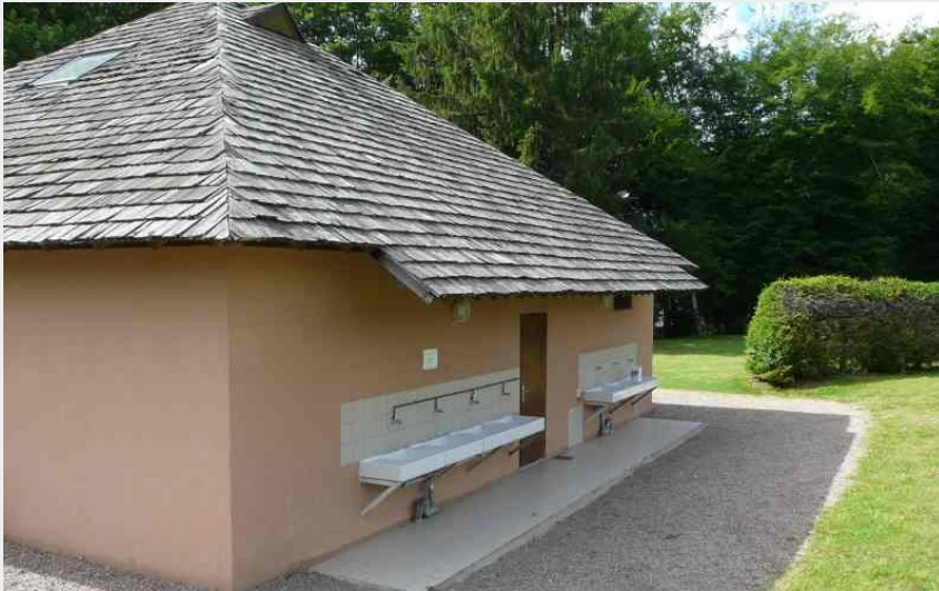
Crédit photo : Camping bloc sanitaire (activital)
